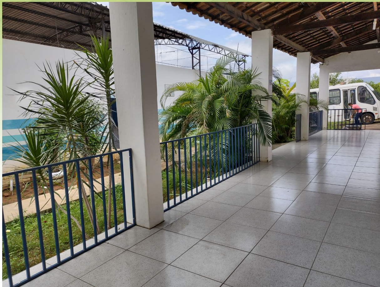
Grade de proteção
